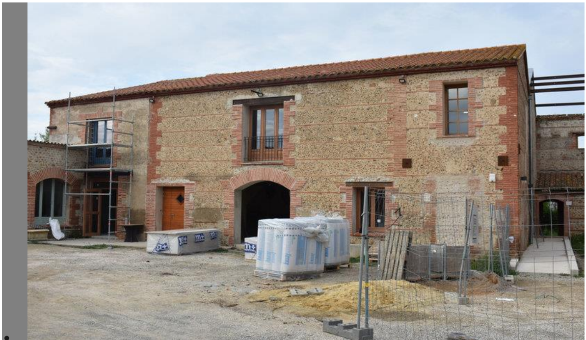
L'edifici que acollirà el nou col·legi de la Bressola ACN.
